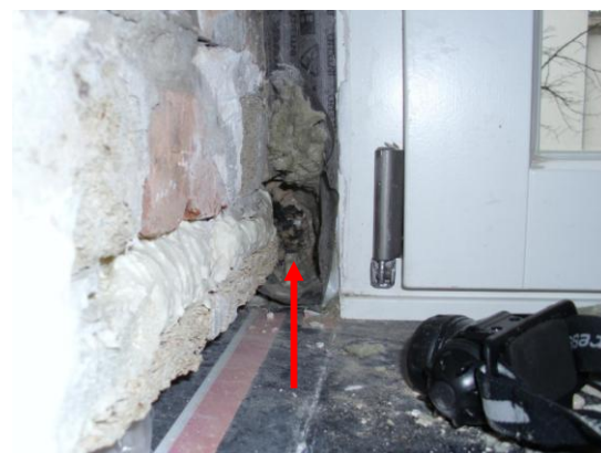
Abb.7: Detail PAK-Summe: 16.000 bis 75.000 mg/kg; Naphthalin zwischen 370 bis 5.700 mg/kg
