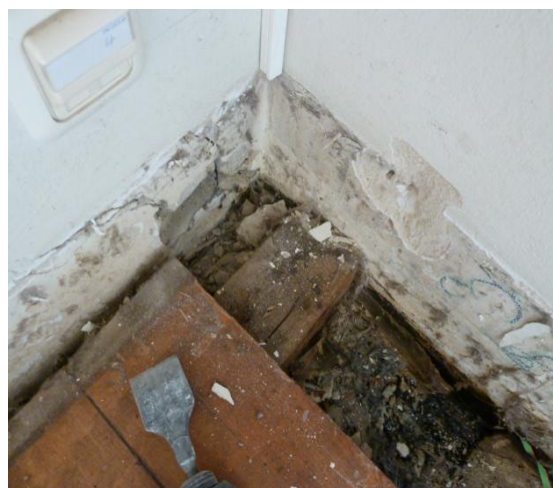
Abb.14: horizontale Bodenabdichtung (5.100 mg/kg Naphthalin, 2.700 mg/kg BaP, 70.000 mg/kg Summe PAK)
