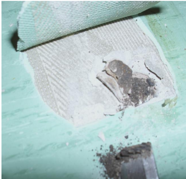
Abb 11: Homogenasphaltplatte unter Bodenbelag;
